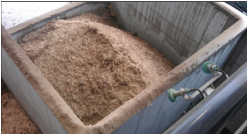
Sekce zásobníku s čidly snímání hladiny
