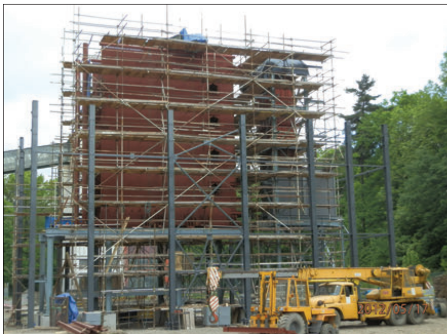
Pohled na ocelovou konstrukci kotle
