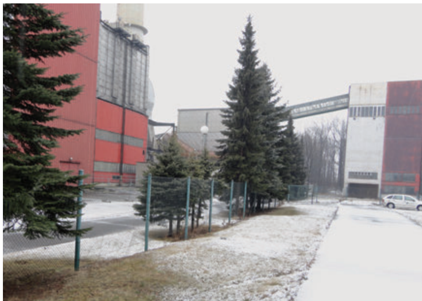
Areál před výstavbou
