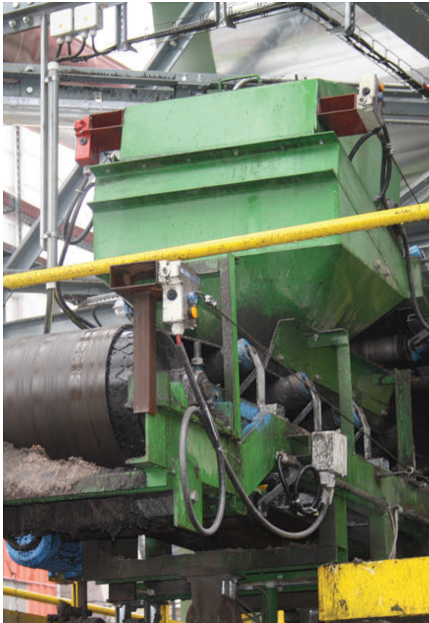
Pohled na technologické části bioelektrárny
