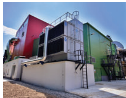
Pohled na dokončenou bioelektrárnu Dalkia ve Sviadnově
