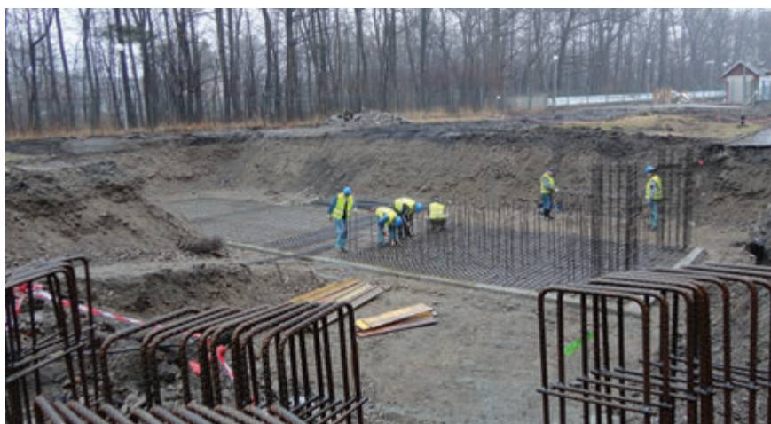
Obr. 7 – Armování základů kotle
