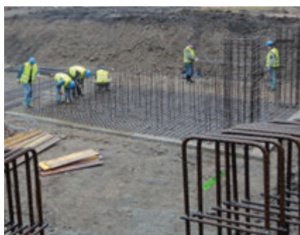
Armování základů pod kotel
