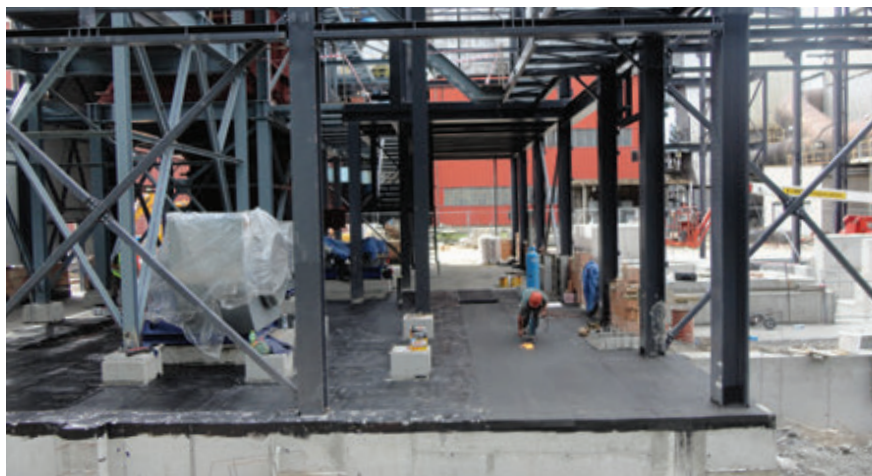
Stavební práce v kotelně
