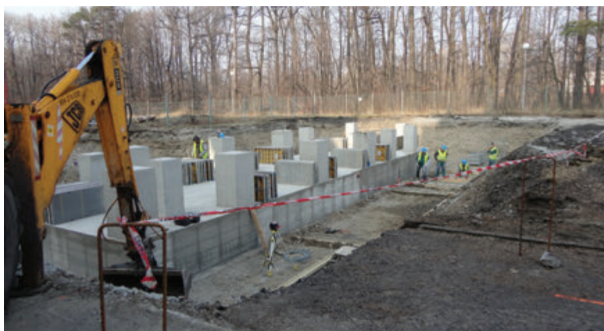
Betonování patek pod kotlem
