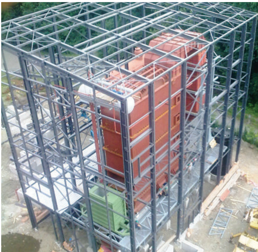
Stav montáže kotelní k 4. 7. 2012
